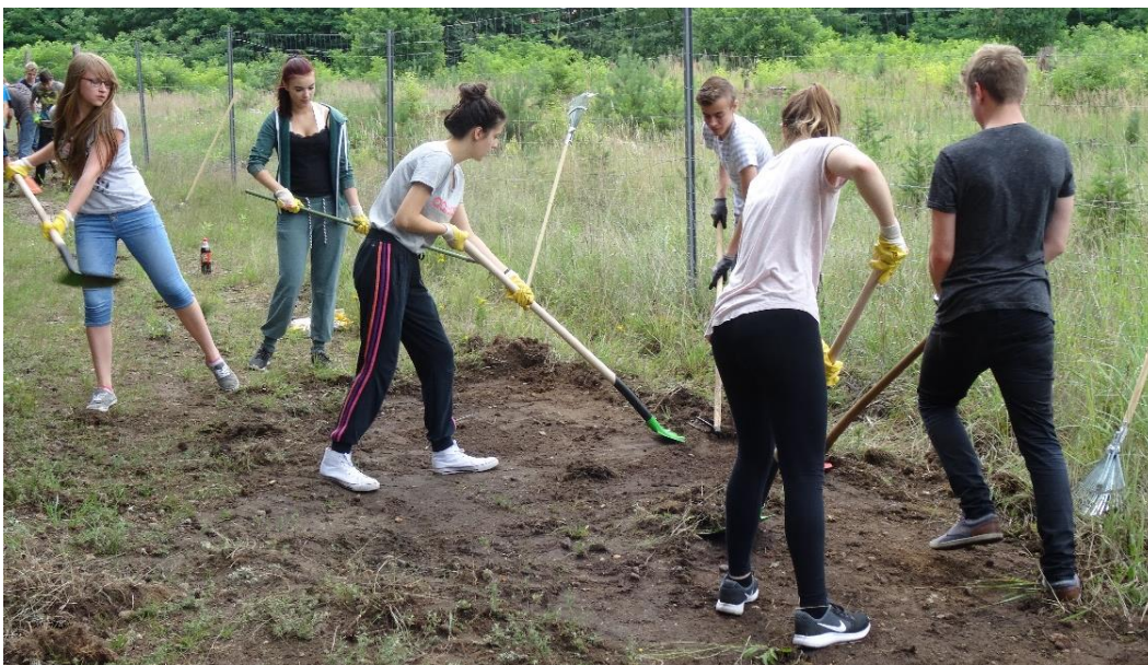
Jugendliche des Gymnasiums beim Freilegen eines Betonweges Anfang Juli 2017
